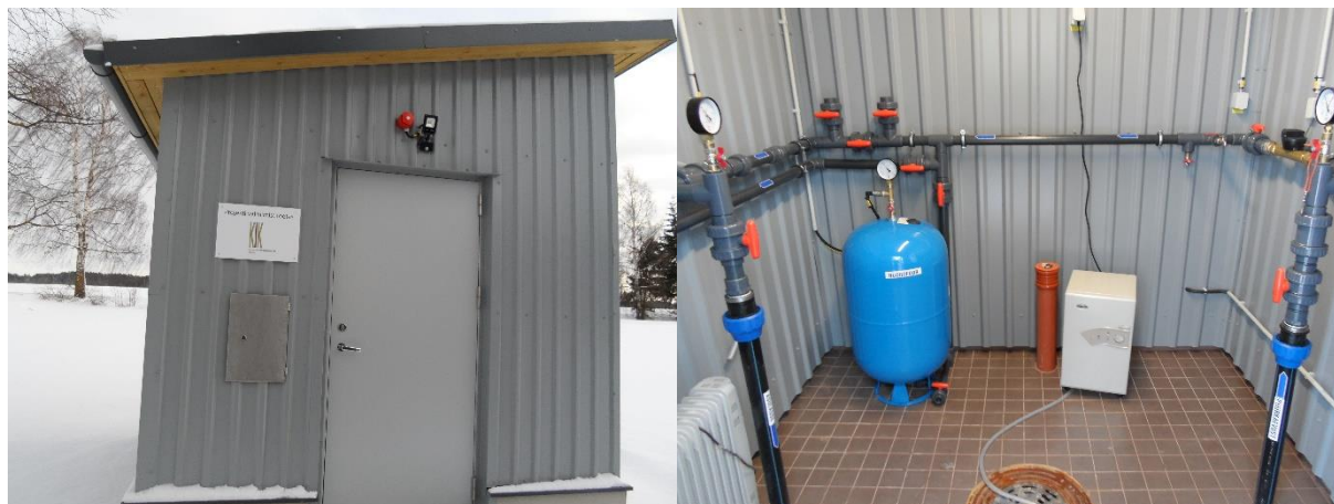
Joonis 5.8 Aardla puurkaevupumpla
