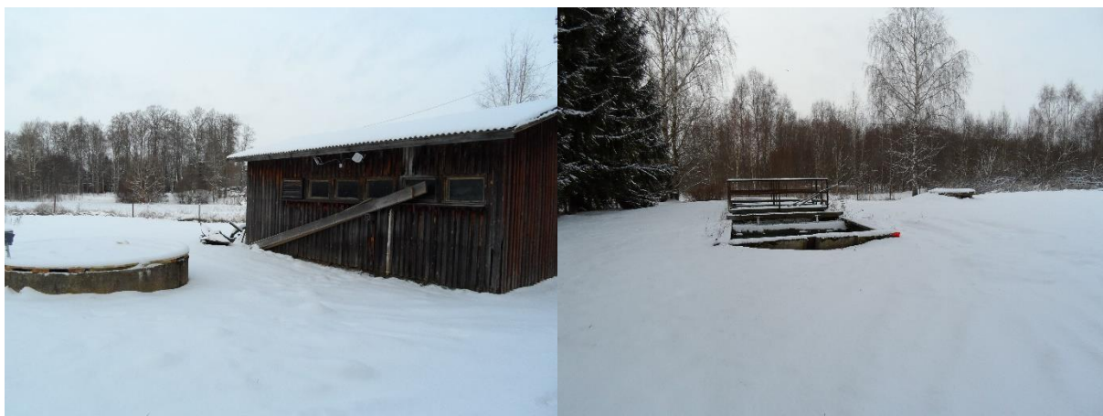
Joonis 6.1 Võnnu reoveepuhasti
