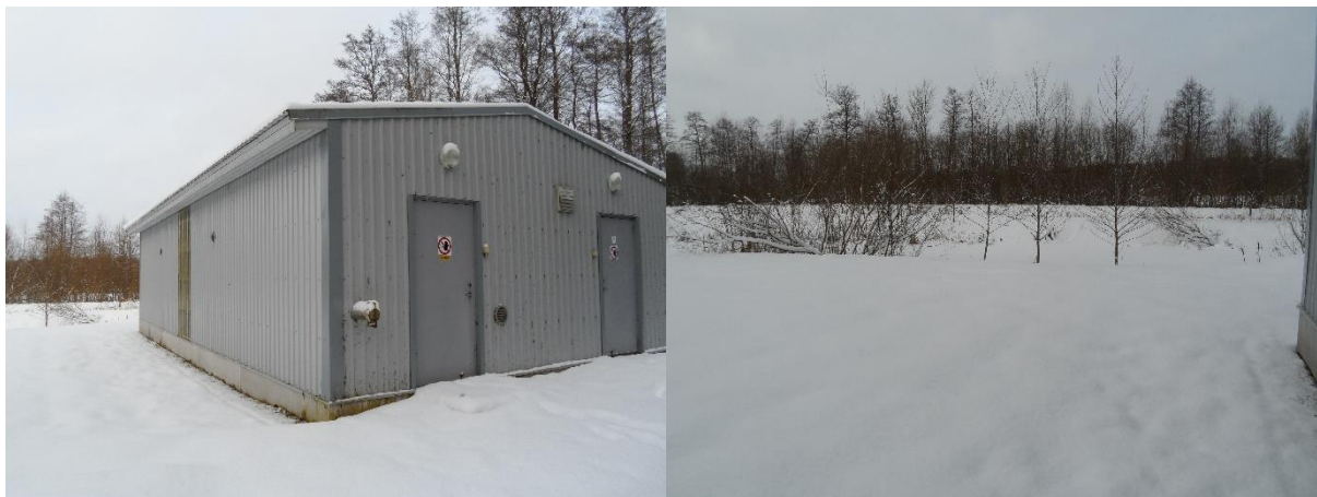
Joonis 6.2 Kaagvere reoveepuhasti
